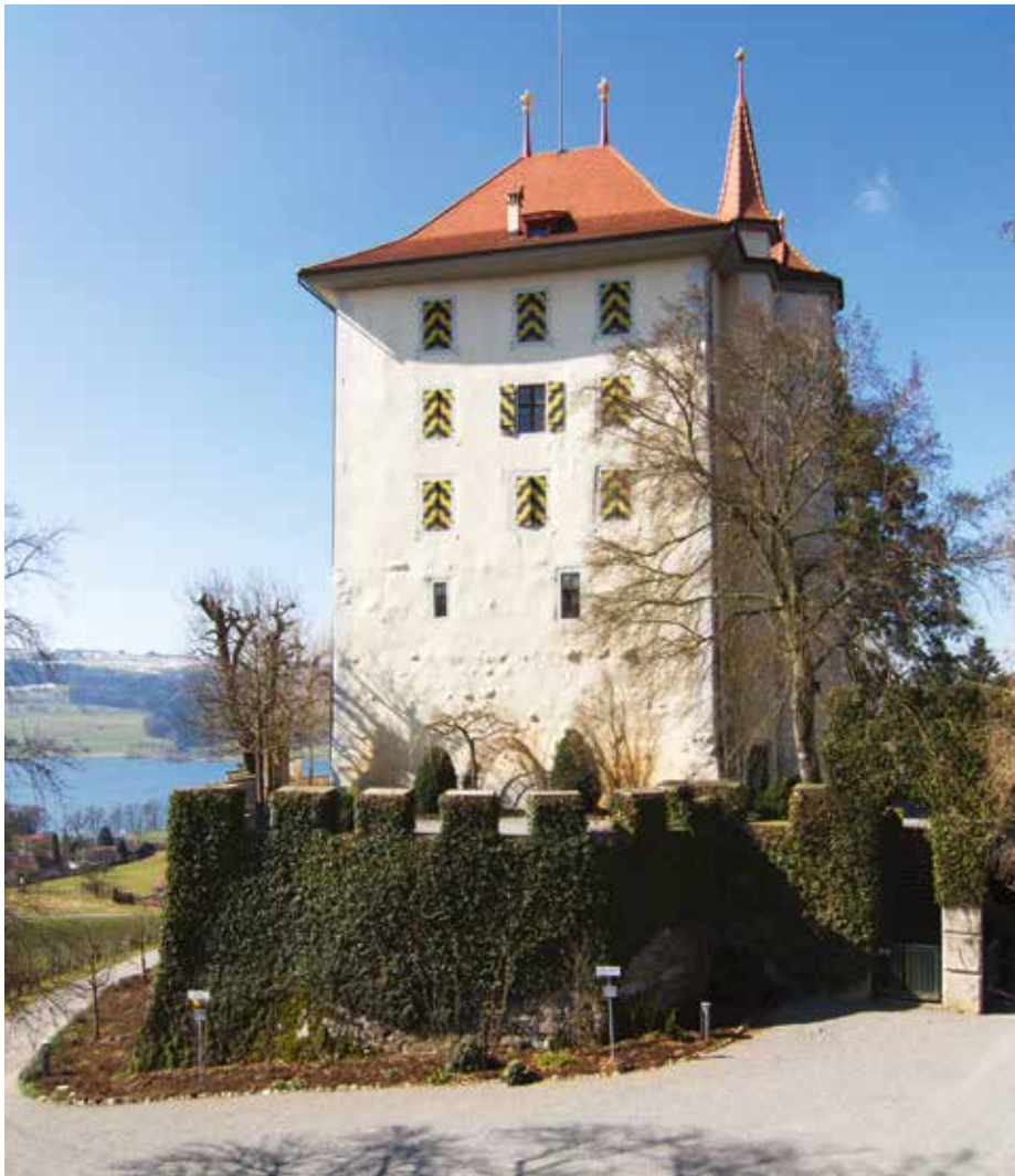
Abb. 16: Ansicht der Ostseite des Schlossturms von Heidegg (Eingangsseite). Am Sockel des Turms sind die vorstehenden Steine des Megalith-Mauerwerks erkennbar. Blick nach Westen.
