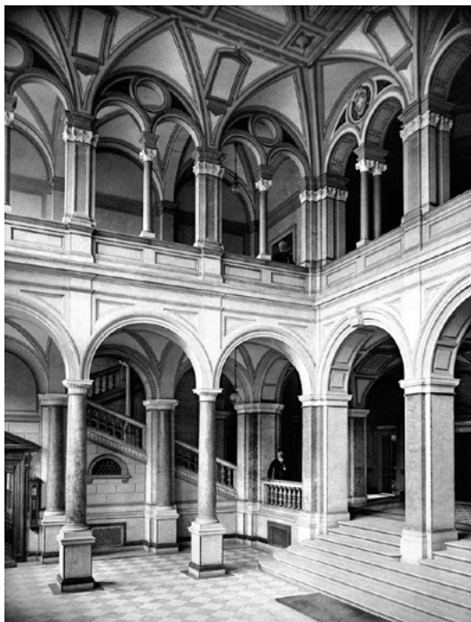
Abb. 2: Bögen und Gewölbe statt Kabelkanäle im Ostteil des Palais fédéral
