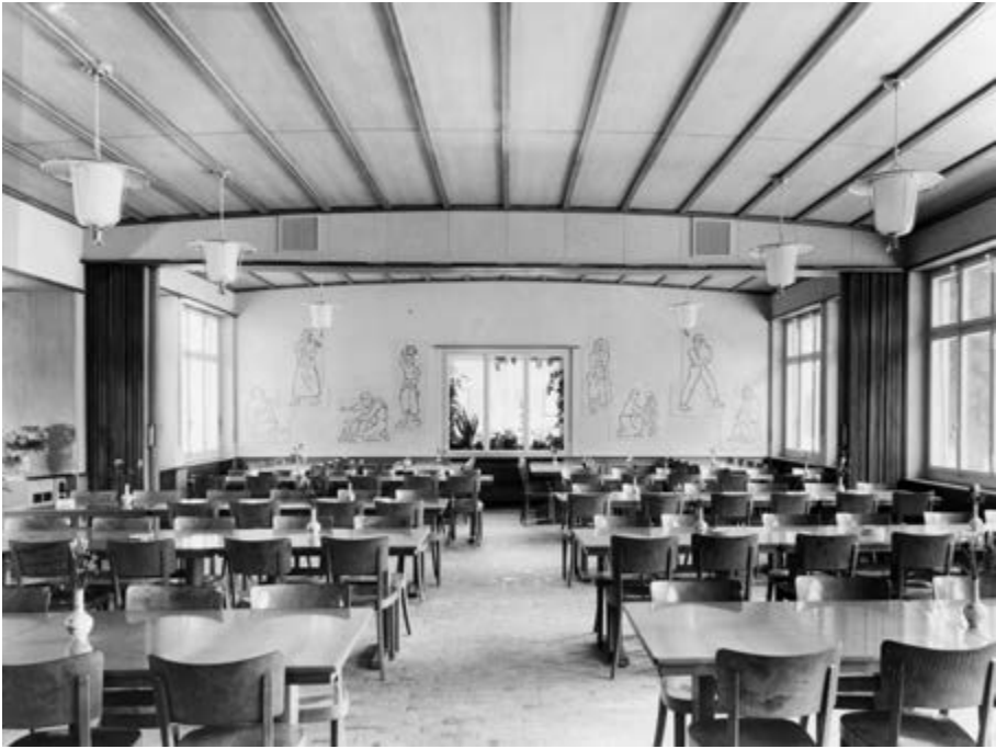
Abb. 68: Blick in den Speisesaal des 1953 eröffneten Wohlfahrtshauses der Porzellanfabrik, fotografiert von Hans Zaugg (1926–2012).
