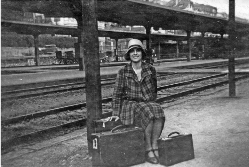
Abb. 40: Anne-Françoise Perret-Gentil am Bahnhof Neuenburg (1930) vor der Abreise nach Paris: Ab 1941 ist sie leitende Mitarbeiterin mehrerer Widerstandsgruppen, wird im August 1944 nach dem KZ Ravensbrück deportiert, wo ihr das Schweizer Konsulat während Wochen jegliche Hilfe verweigert.
