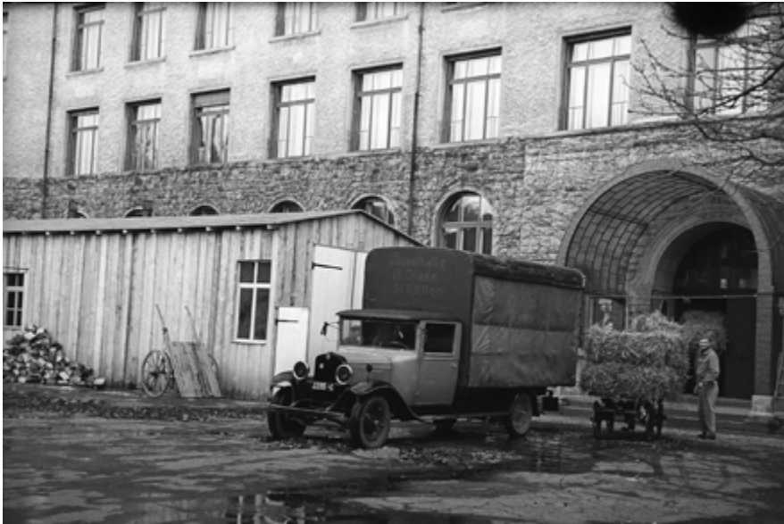
Abb. 2: Anlieferung von Stroh ins Hadwig-Gebäude mit der Desinfektionshütte im Vordergrund.
