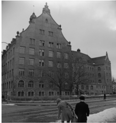
Abb. 1: Aussensicht auf das Schulhaus Hadwig auf einer Fotografie von Walter Scheiwiller.
